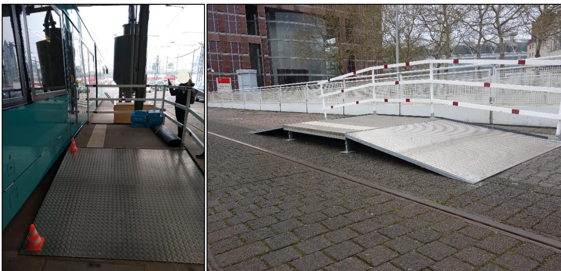
Abbildung 16: Be- und Entladungsrampen 101
